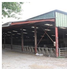
Bâtiment dit du bas
