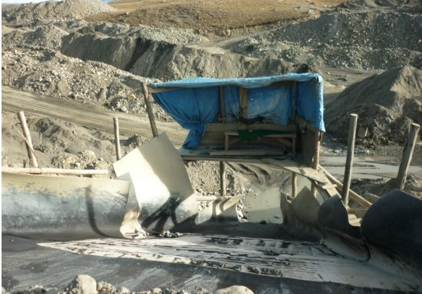
Figure 19: Photo de la première partie du Canaleta , où est deversée la terre
