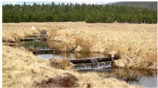
Photo 15- Travaux de restauration de la tourbière de la Sénégrière ( © PN Cévennes)
